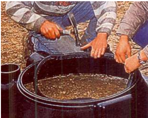
Montage der Dichtung zum Teleskop. Vor Montage unbedingt mit geeignetem Montagefett einfetten!
